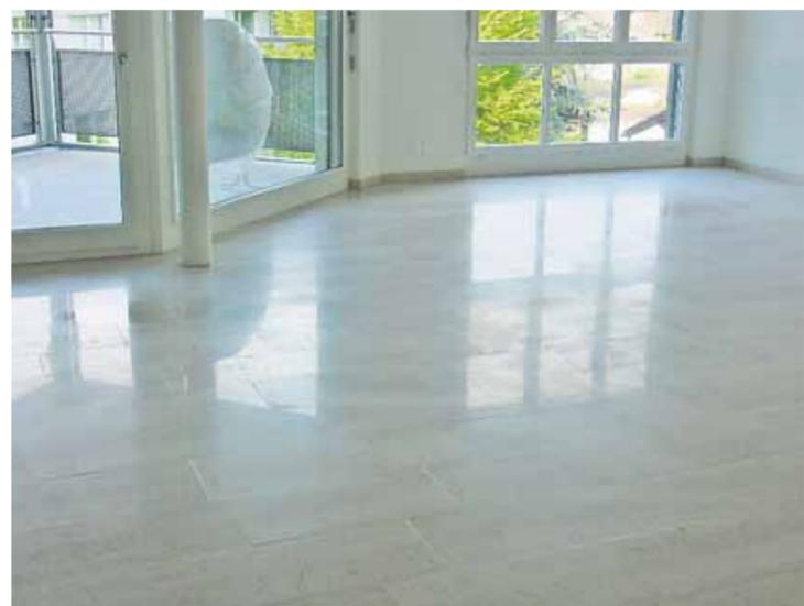
Vorher: Wird mit Zement ausgefügt, entsteht auf den Marmorplatten ein Zementschleier, der auf dem kalkhaltigen Gestein nicht wie auf Granit mit Säure entfernt werden kann.
