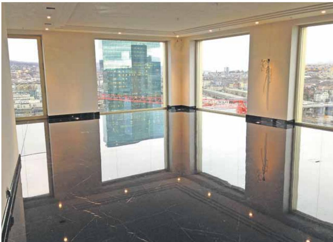
Ein fugeneben geschliffener Marmorboden in einer Eigentumswohnung im Mobimo Tower.
