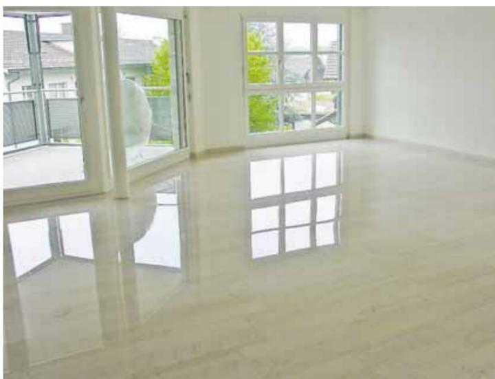
Nachher: Die Fugen sind nach dem Schleifen und Polieren des Bodens kaum noch zu sehen, und auch überstehende Kanten sind verschwunden. Ein solcher fugenebener Boden ist am pflegeleichtesten.
